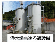
浄水場急速ろ過設備
