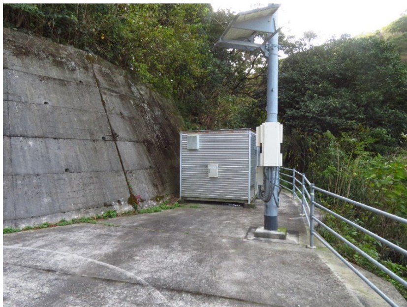
写真 2-2-2-4 備蓄倉庫の整備例
