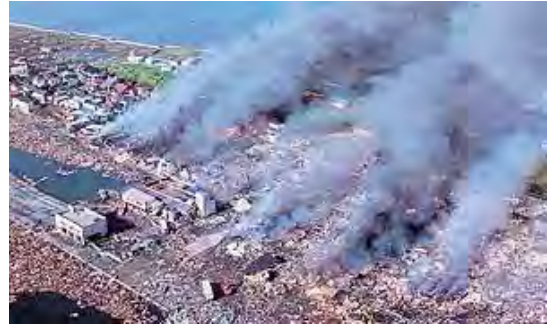
北海道南西沖地震津波(1993. 7. 12)による 奥尻島の被害 (出典：奥尻町)
