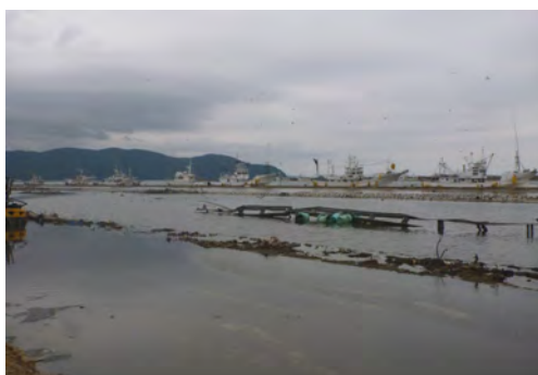
岩手県石巻漁港 (岸壁・用地の沈下)
