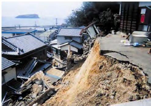
被災した斜面上の集落
