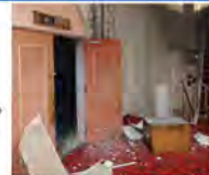
【被災したホテル館内】
