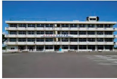
震災遺構 (仙台市立荒浜小学校)
