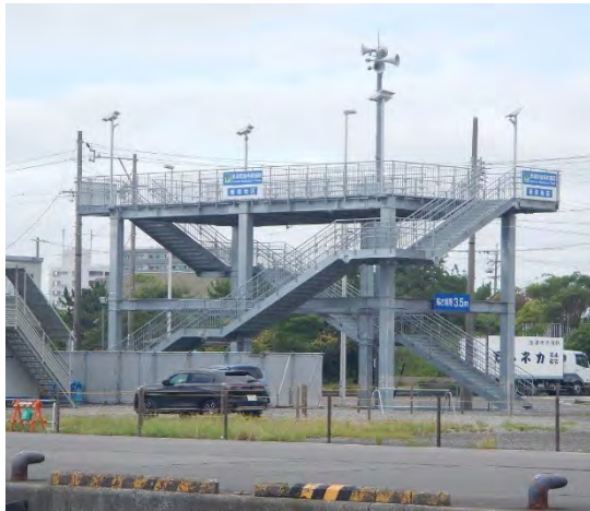
津波避難施設（静岡県焼津市）
