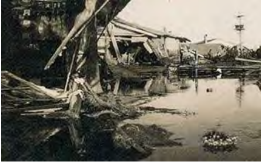
チリ地震津波(1960. 5. 23) による被害
