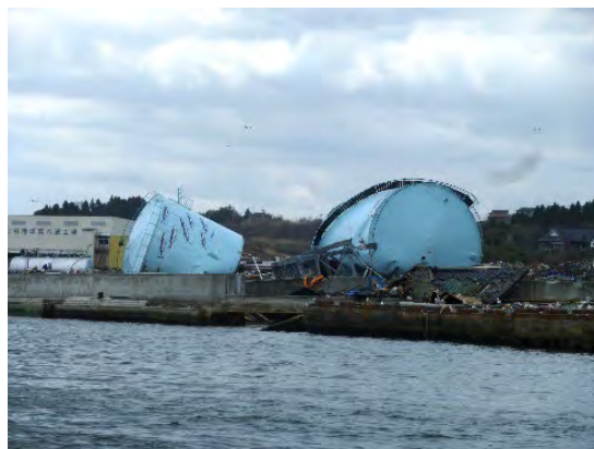
東北地方太平洋沖地震・津波による給油タンクの被害
