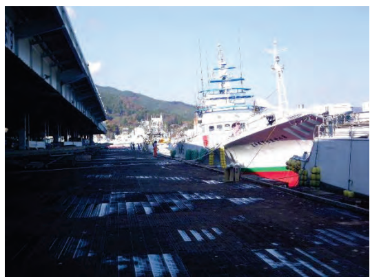
写真-IV-2-3 鋼材を用いた応急嵩上げ (気仙沼漁港)
