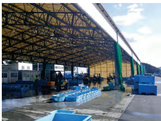
写真-IV-2-1 テント式仮設荷さばき所 (志津川漁港)
