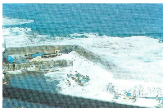
日本海中部地震津波(1993. 5. 26)による被害
