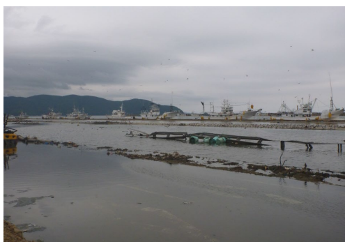
岩手県石巻漁港 (岸壁・用地の沈下)
