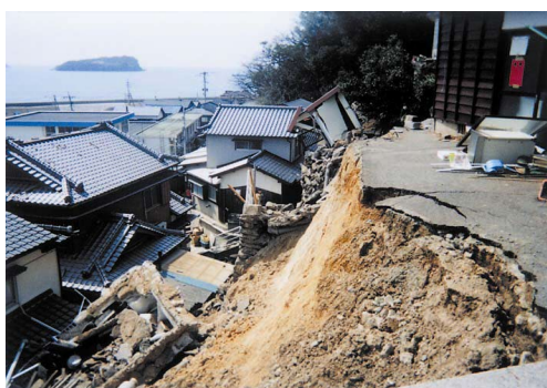
被災した斜面上の集落
