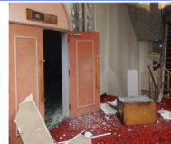
【被災したホテル館内】
