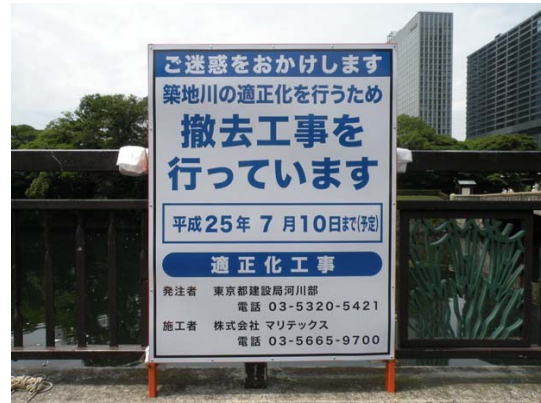
行政代執行中の工事看板
