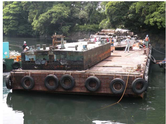
台船に積まれた鋼製栈橋と ボート（写真奥）
