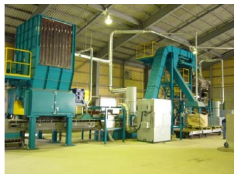
写真 4-5-4 【FRP 破材中間処理場】 処理機械でFRP断片が細粉碎される
