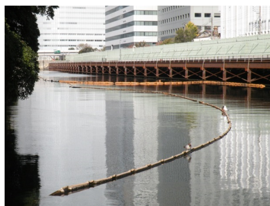
ボートの侵入防止のため 河口付近に敷設されたフェンス
