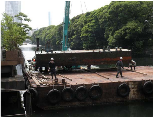
クレーン付台船による 鋼製栈橋の撤去状況
