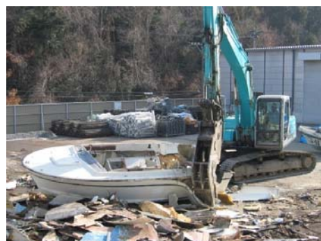
写真 4-5-2 重機による粗破碎状況
