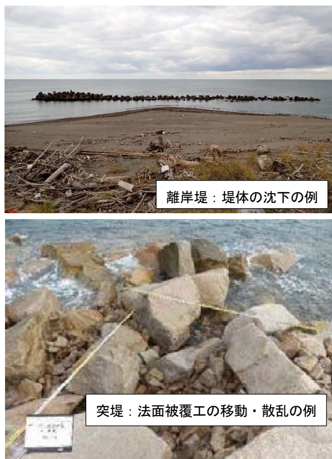
図-3.2 巡視（パトロール）において確認する特徴的な変状の事例
