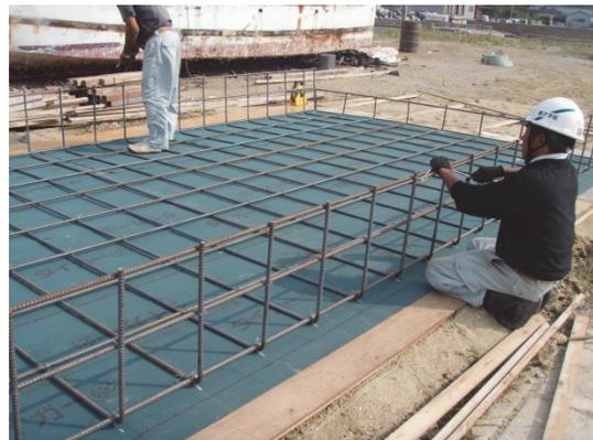
写真-5.11 鉄筋組立状況
