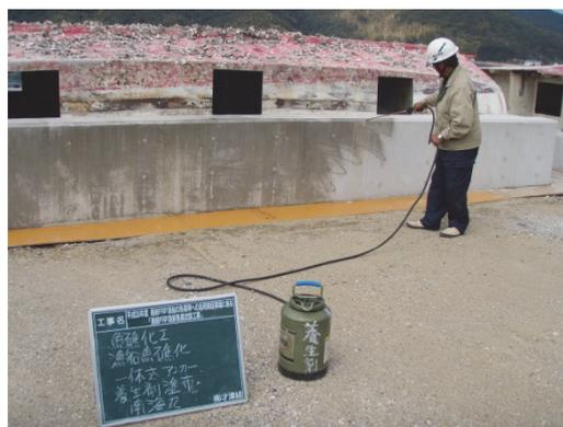
写真-5.17 コンクリート養生材の散布状況
