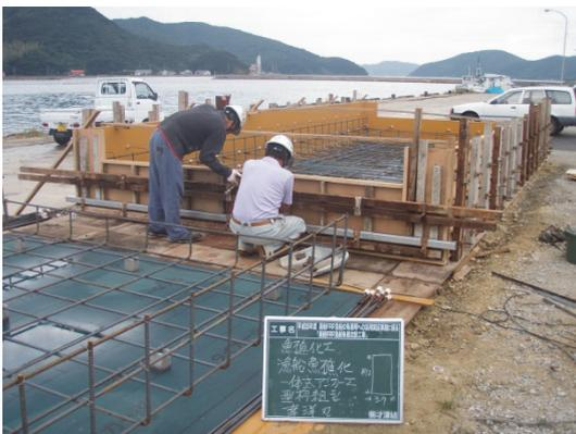
写真-5.12 型枠組立状況
