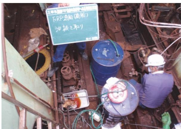
写真-5.13 油抜き取り状況
