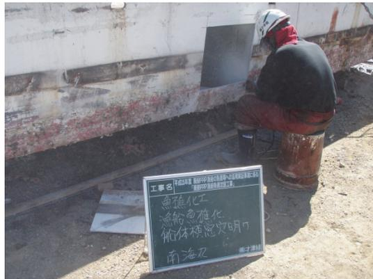
写真-5.9 開口部の切断状況
