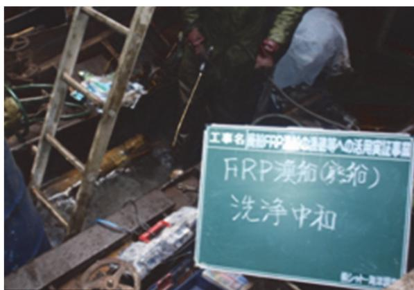
写真-5.5 洗浄状況(油処理剤散布)
