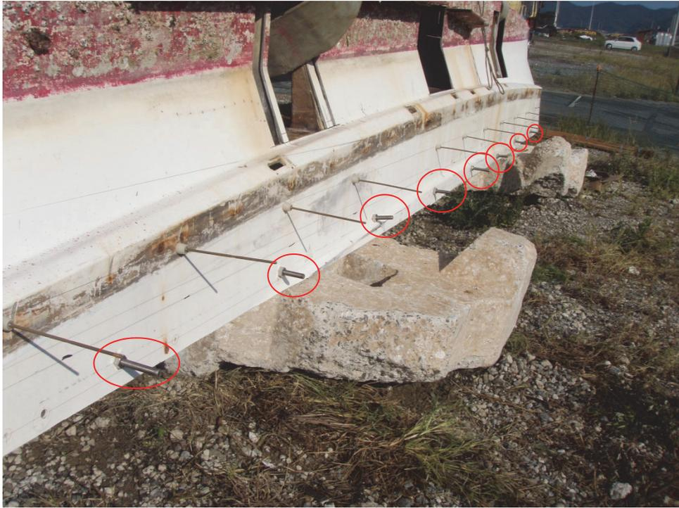
写真-5.8 アンカーボルト(SUS304、φ18mm×L200mm、8箇所/1側面×2側面)
