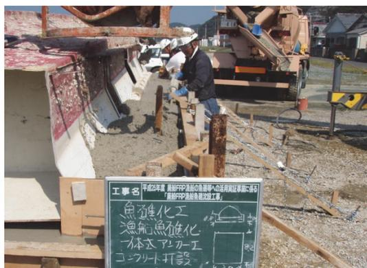
写真-5.16 FRP 漁船の埋め込み状況
