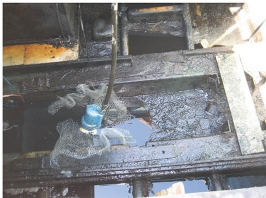
写真-5.22 油抜き取り状況
