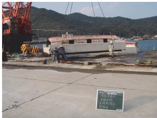
写真-5.19 FRP 沈船魚礁の積込状況
