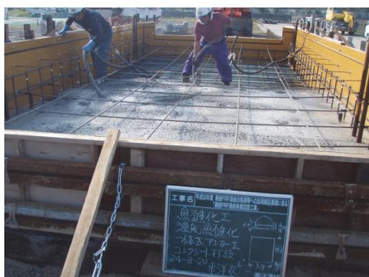
写真-5.14 コンクリート打設状況
