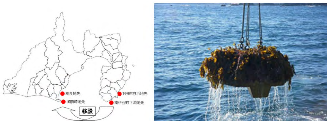
図 5-24 ブロックの移設（南伊豆町に仮置き、海藻の着生後に相良、御前崎に運搬） 17)
