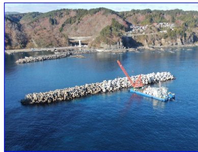
非航旋回起重機船による据付状況
