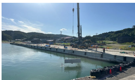
残置型枠ブロックを水中据付
