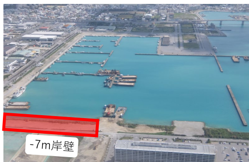
施工位置（糸満漁港）
