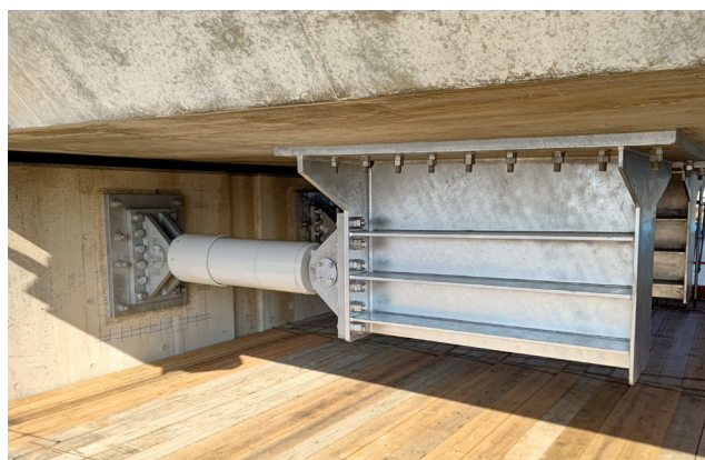
制震ダンパー取付後
