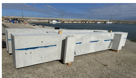
搬入した残置型枠ブロック
