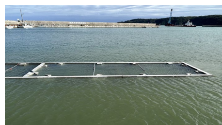
残置型枠（口の字）水中組立
