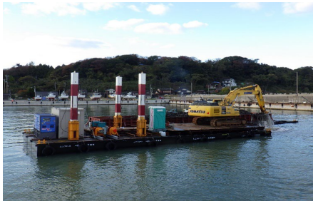
3Dマシンコントロールバックホウによる浚渫
