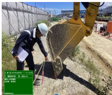
GNSSによる施工機械の位置
