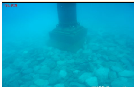
捨石均し状況
