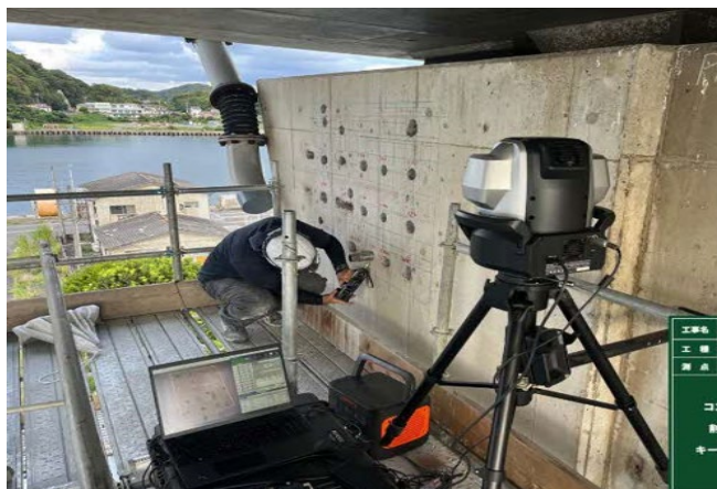
三次元測定機により削孔位置を測定
