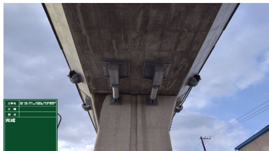
制震ダンパー設置後の橋梁
