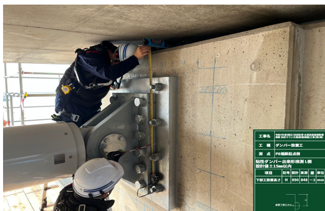
制震ダンパー取付作業
