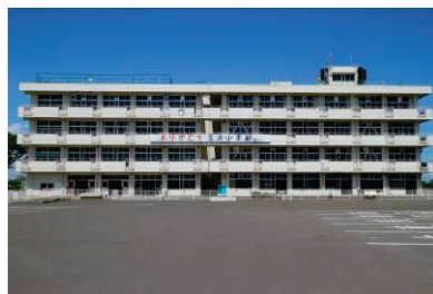
震災遺構 (仙台市立荒浜小学校)
