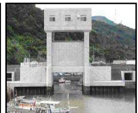
津波・高潮対策としての水門整備
