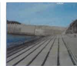
物揚場等の係留施設
