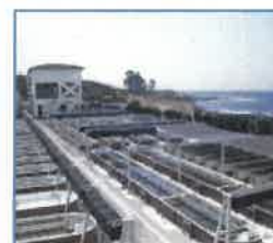
魚類・貝類 種苗生産施設
