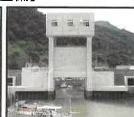
津波・高潮対策としての水門整備
