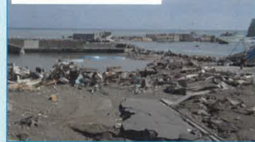
被災当時の漁港状況
