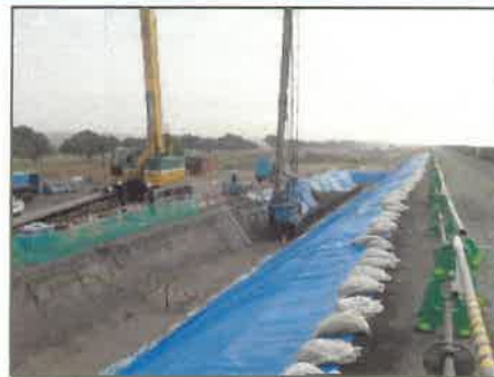
鋼矢板打設による耐震対策
