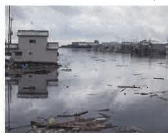
【東日本大震災被害状況】
