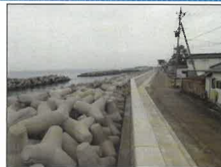
消波ブロックの設置や堤防嵩上げによる越波の防止
