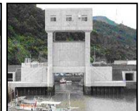
津波・高潮対策としての水門整備
