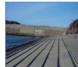
物揚場等の係留施設
