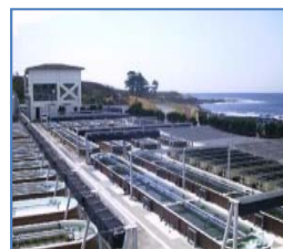
魚類・貝類 種苗生産施設
