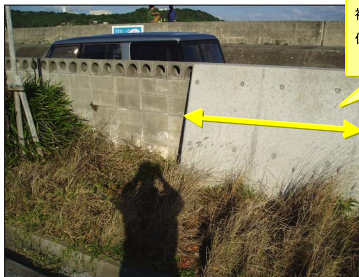
写真 - 4 災害復旧後の擁壁
