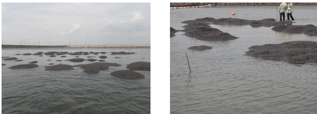
写真 2.2.2-1 砕石の敷設状況 (施工直後)
