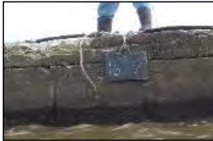
【上部工の欠損：評価「b」】
