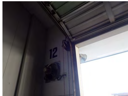
図 e-2-1-62 シャッターの引上げチェーンの発生状況
