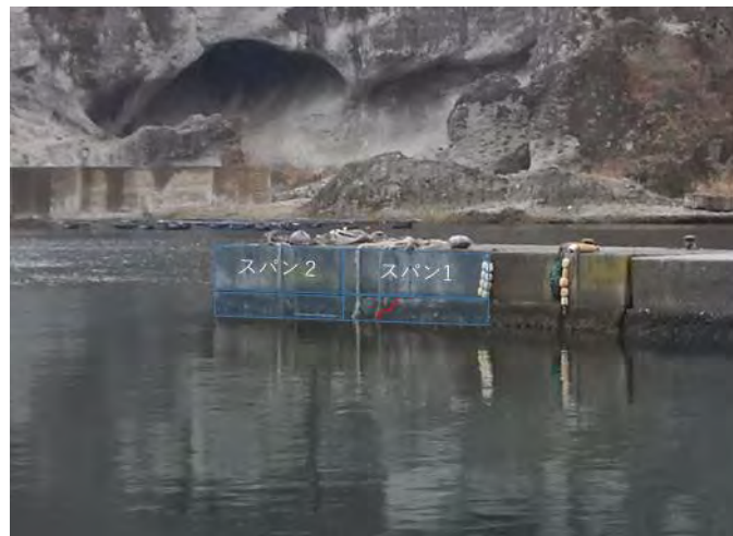
図 e-1-3-13 牛滝漁港における中防波堤の状況
