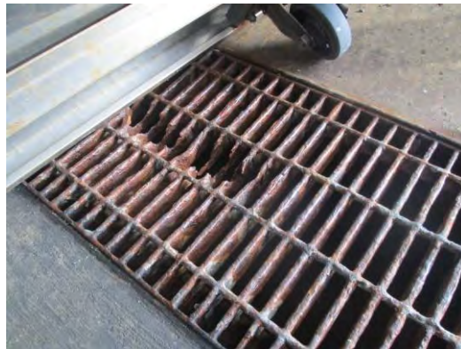
図 e-2-1-60 新市場におけるグレーチングの発錆状況
