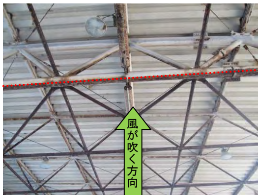
図 e-2-1-57 梁の向きによる発錆状況の違い
