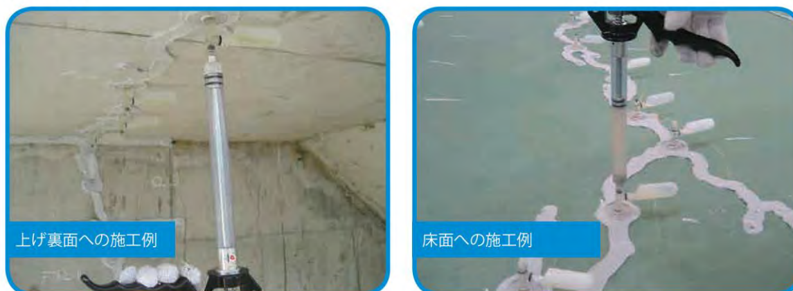
図 e-2-2-2 ひび割れ補修の施工例
