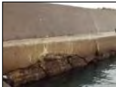
【本体工の欠損：評価「a」】
