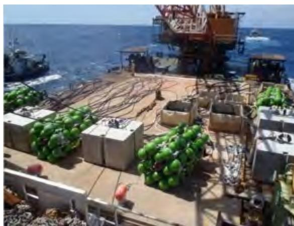
図 6.7 中層浮魚礁とコンクリートブロックアンカー
