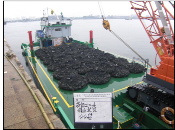
図 5-9 袋詰めユニットの積込・海上運搬状況
