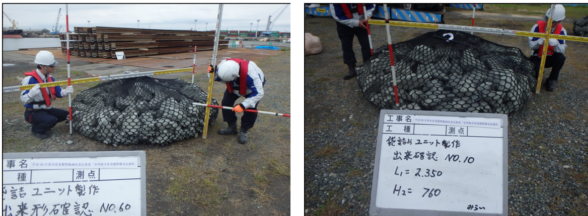
図 5-12 出来形形状測定状況
