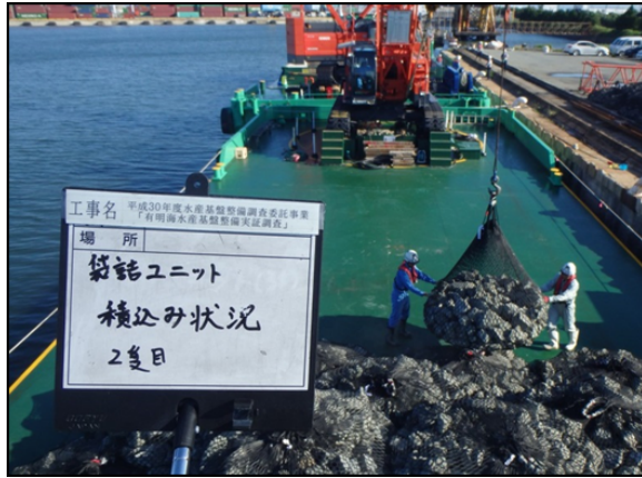
図 5-9 袋詰めユニットの積込・海上運搬状況
