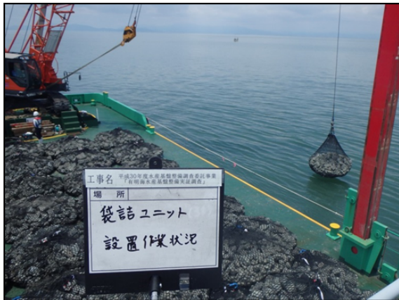
図 5-10 袋詰めユニットの据付状況
