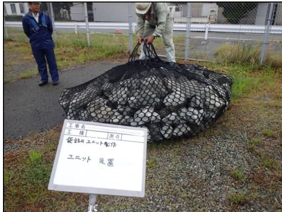
図 5-6 袋詰めユニット製作および転置状況
