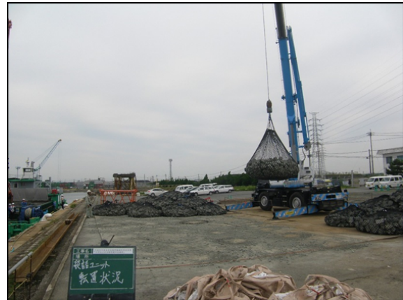
図 5-6 袋詰めユニット製作および転置状況
