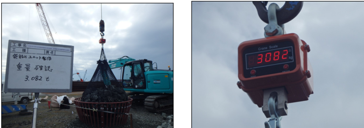
図 5-13 袋詰めユニットの重量測定状況
