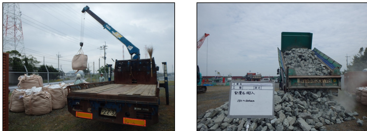
図 5-4 資材（袋詰めユニット、割り石）搬入状況
