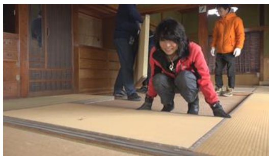
写真 古民家改修による活用
