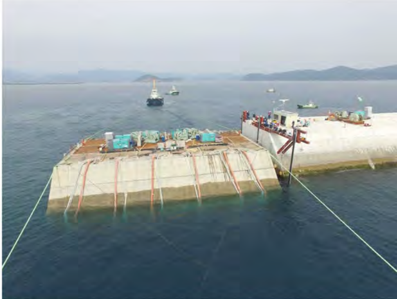
ケーソン据え付け状況。従来は動揺するケーソン上に人が乗って測量をしていた。
