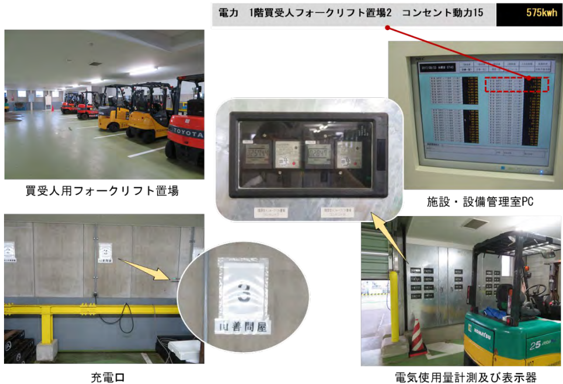
図 4. 2. 3 電動フォークリフト使用料・電気料の自動管理（大船渡市魚市場）
