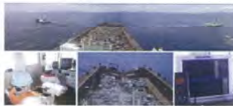
施工状況の様子、遠隔操作で石材を投入する
