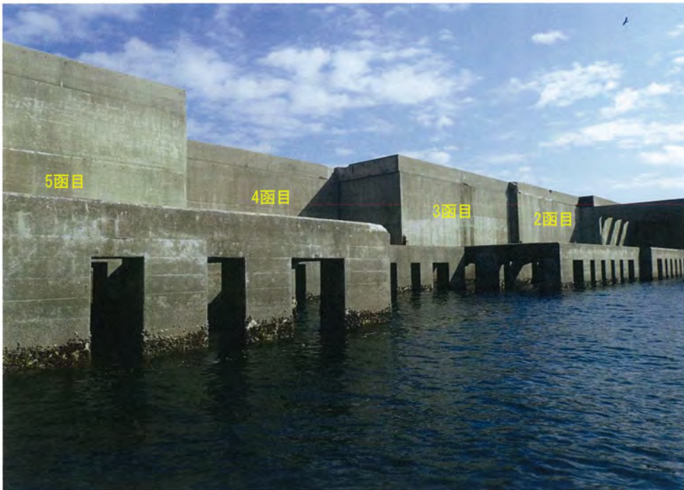
二町谷南防波堤 港外側 4函目 (気中部)
