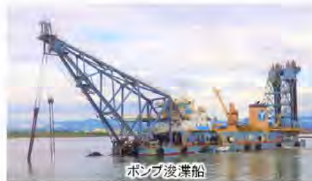
ポンプ浚渫船
