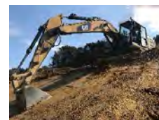
③ ICT施工技術仕様の建設機械
