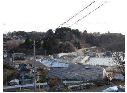
(防潮堤と高台移転住宅)
