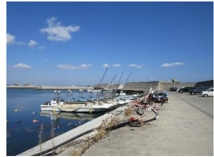
(漁港整備の状況)
