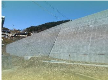
(防潮堤完成部分)
