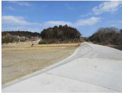
(国道海側の嵩上用地／工事中)
