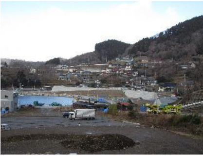
(防潮堤汚整備中の漁港の現状)
