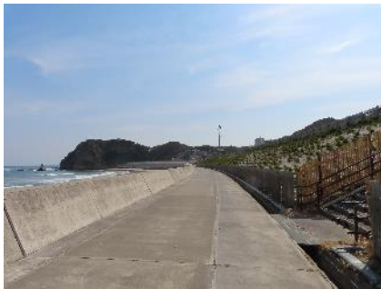
(海岸堤防と防災緑地)
