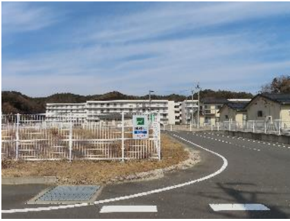
(災害公営住宅)
