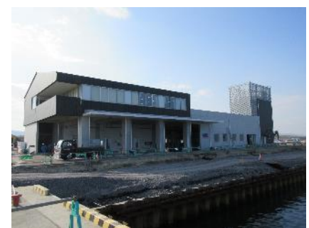
(漁港内の荷捌所・漁協事務所)
