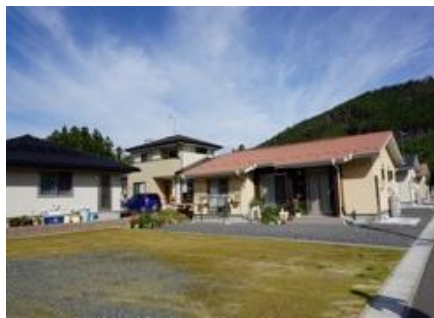
(高台移転住宅)
