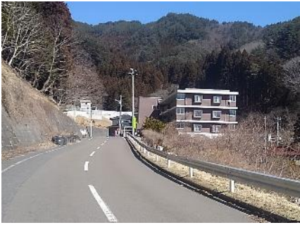
(高台の災害公営住宅)
