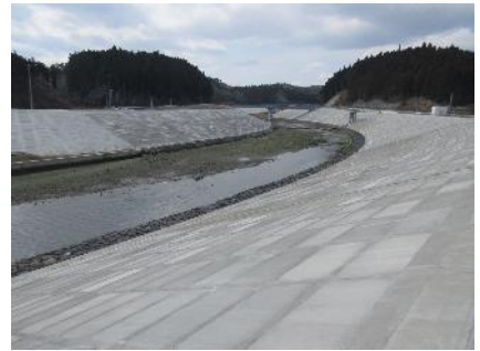
(議論になった河川堤防)
