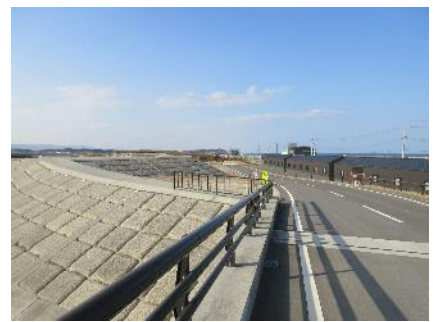
(河川堤防と一体型の防潮堤)
