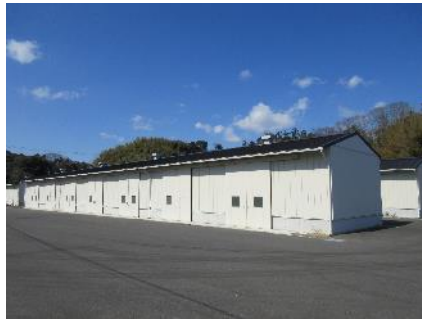
(漁集用地内の漁具倉庫)
