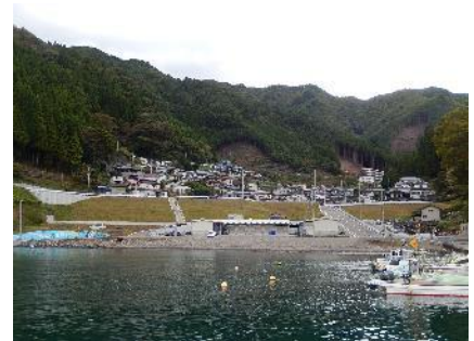
(大規模防潮堤のない漁港)
