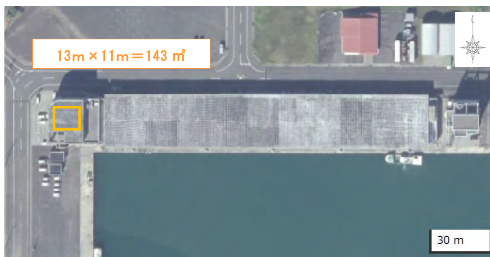
図 1.3-11 荷さばき所（管理棟）屋上の太陽光発電施設の設置場所
