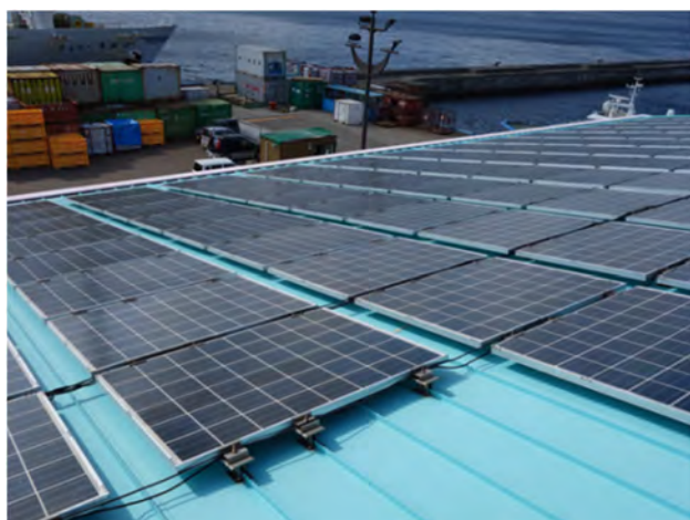
写真 3.9 傾斜屋根の設置例
