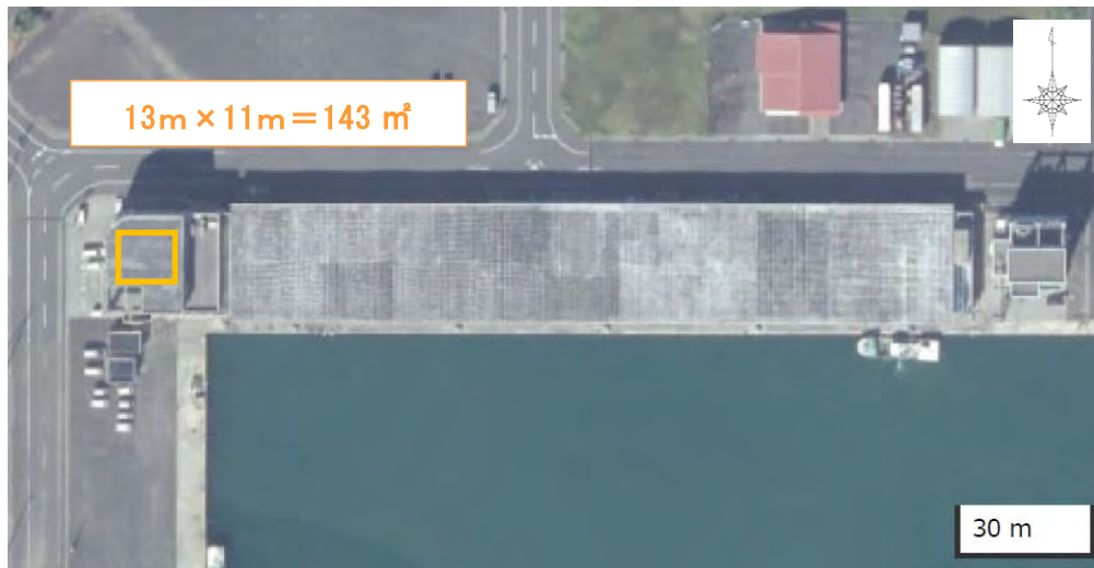
図 1.2-4 荷さばき所（管理棟）屋上の太陽光発電施設の設置場所
