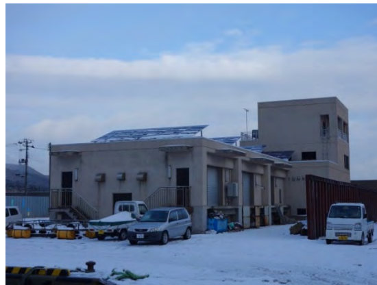
写真 3.7 パネル上への積雪の例
