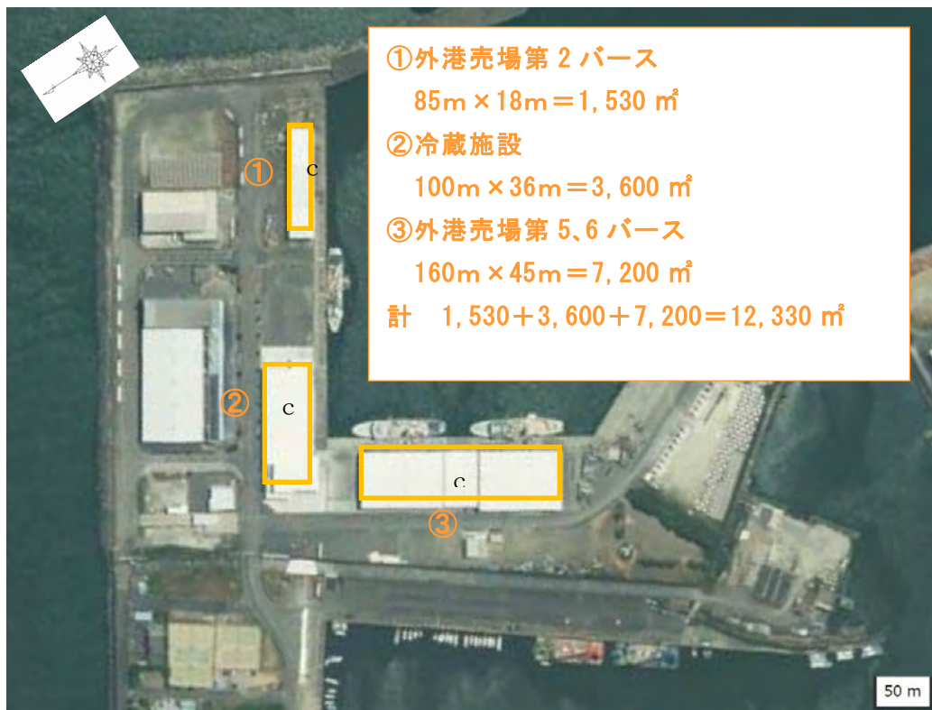
図 1.4-11 a 地区の太陽光発電施設の設置場所 出典：国土地理院撮影の空中写真（2020 年撮影）
