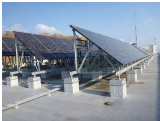
図 2.9 太陽光発電システム設置
