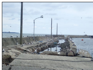
地震・津波により防波堤が沈下 (珠洲市鶴飼地区)
