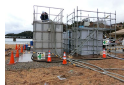
処理場応急復旧
