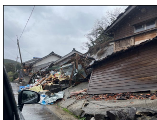
家屋の倒壊 (珠州市狼煙地区)
