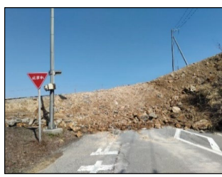
崖崩れにより海岸に向かう道路が封鎖 (輪島市・里地区)
