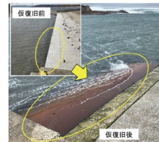
赤神漁港(船揚場の仮復旧状況)
