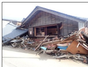
地震・津波により家屋が全壊 (珠洲市鶴飼地区)
