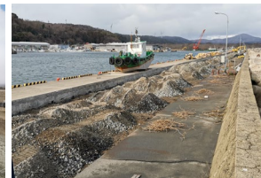
破碎材を用いた 岸壁背後の応急復旧状況
