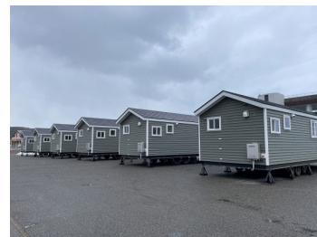
志賀町でのトレーラーハウス設置
