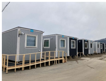
輪島市でのムービングハウス設置
