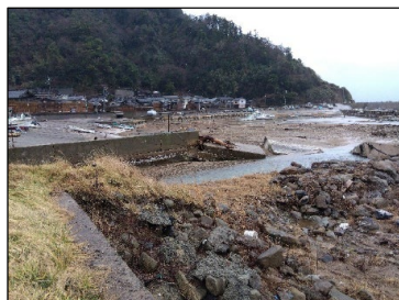
豪雨により大量の流木・土砂が流入
