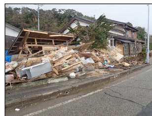
地震・津波により家屋が全壊 (珠洲市寺家地区)
