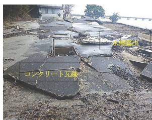
排水処理施設の被災状況(比那地区)
