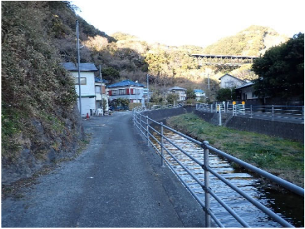
川沿いの管路埋設路線
