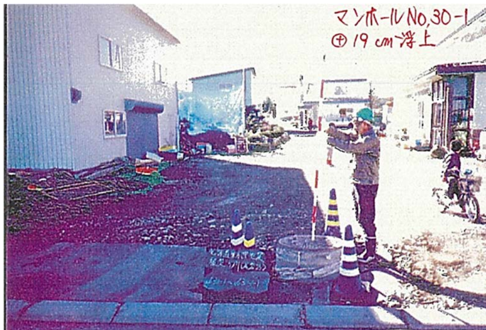
マンホールの浮上被害 （尾岱沼地区）
