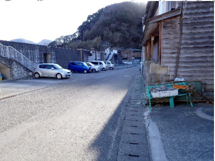
漁港沿いの管路埋設路線
