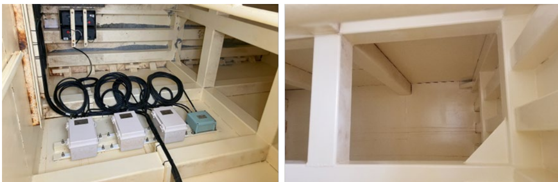
図 f-1-20 浮体内部（左：底面、右：天井）
