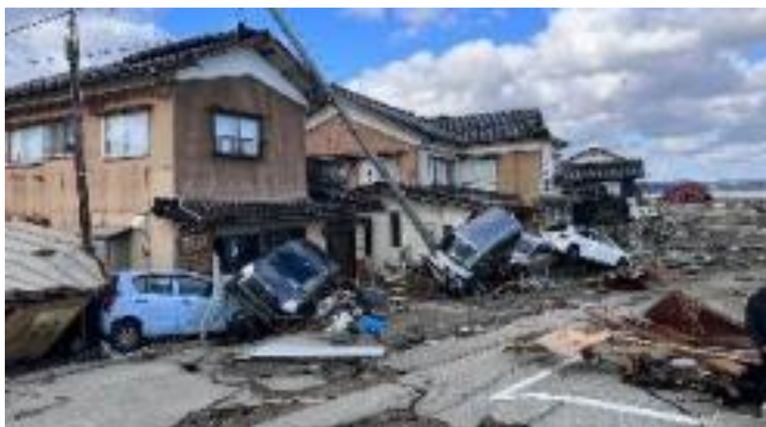
写真 1-1-6-1 鵜飼漁港周辺の津波による被害状況写真
