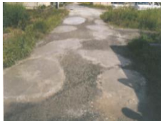
農道の窪みの補修
