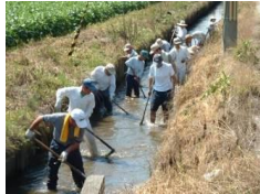
水路の泥上げ
