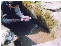
水路のひび割れ補修
