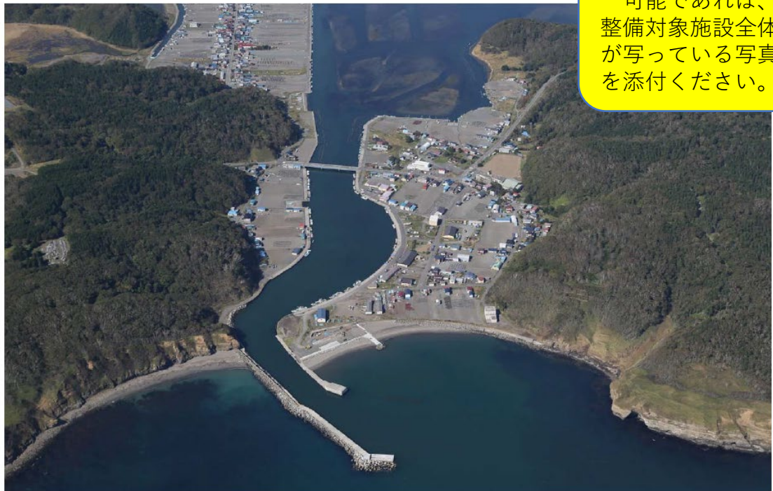
事業施工箇所写真(本港地区)
