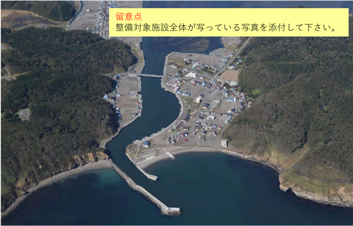
事業施工箇所写真（本港地区）
