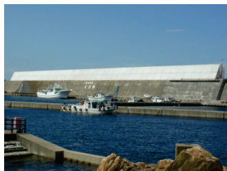
嵩上げにより越波を防ぎ、港内静穏度を確保
