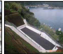
漁村における津波避難対策（避難施設、避難経路の整備）
