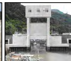
津波・高潮対策としての水門整備
