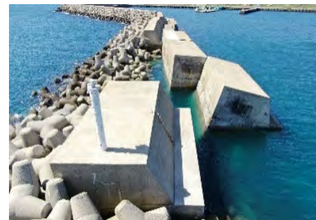
1. 漁港、海岸等の災害復旧事業 防波堤の損壊（令和4年台風第11号）
