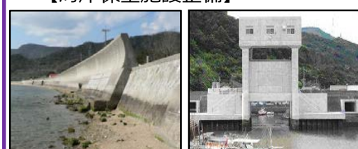
津波、高潮による被害を未然に防ぐため海岸堤防の整備を推進 津波・高潮対策としての水門整備
