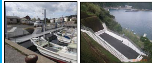
漁業作業の効率化と安全対策のための漁港整備（岸壁改良） 漁村における津波避難対策のための漁港整備（避難地、避難路の整備）
