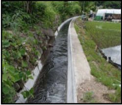
老朽化した用水路の整備・更新
