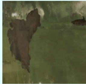
床面の剥離により 雑菌繁殖のおそれ 柱や壁の腐食により 異物混入のおそれ
