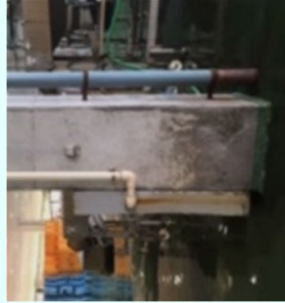
床面の剥離により 雑菌繁殖のおそれ 柱や壁の腐食により 異物混入のおそれ
