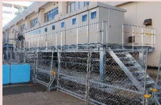
電源施設の高架化
