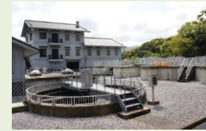
漁業集落排水施設
