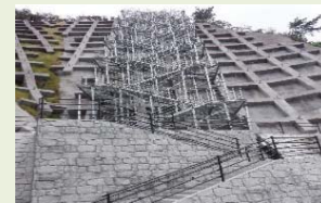
防災安全施設 (土砂崩壊防止施設)
