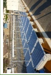
太陽光パネルの設置
