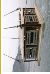
魚礁の新設・移設
