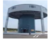
津波避難タワー
