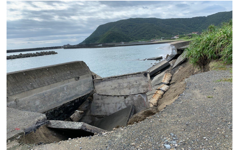
④防波堤のブロック飛散(沖縄県糸満漁港)
