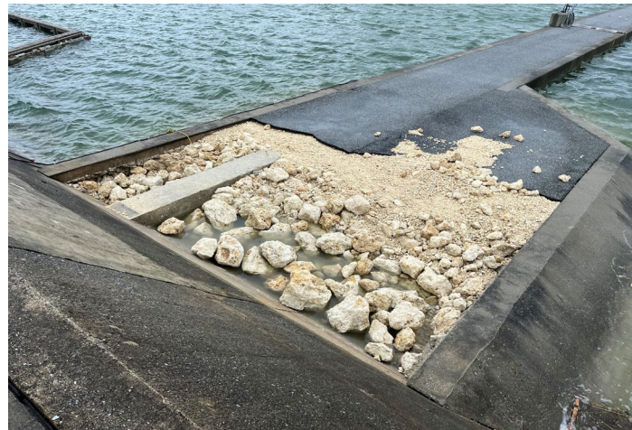
③堤防の損傷(沖縄県海野漁港)
