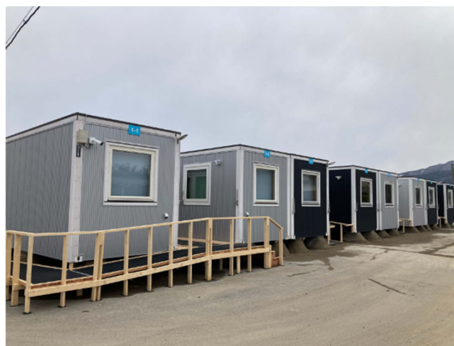
輪島市でのムービングハウス設置
