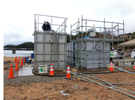
処理場応急復旧
