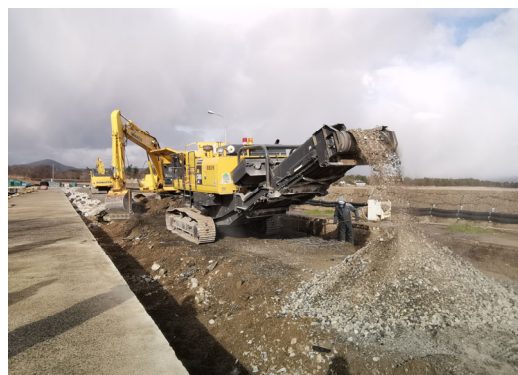
自走式破碎機による コンクリート破碎状況
