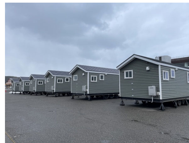
志賀町でのトレーラーハウス設置
