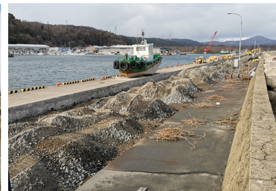
破碎材を用いた 岸壁背後の応急復旧状況
