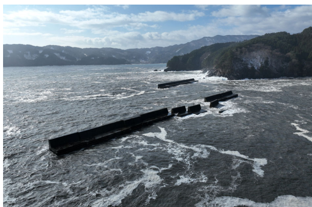
(風浪による防波堤の倒壊)
