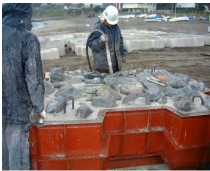
植石ブロックの製作状況
