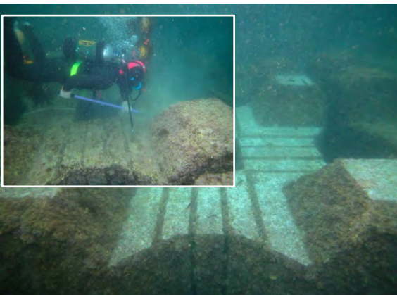
図 7-D5-8 ダイバーによる岩盤清掃
