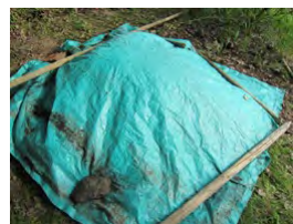
③ 雨水の浸入防止と 保温のためシートで 覆う
