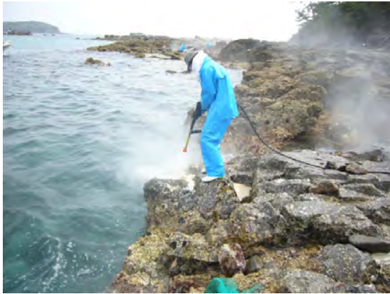
図 7-D5-5 高圧洗浄機による岩盤清掃
