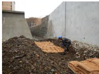
用水での施肥材設置状況
