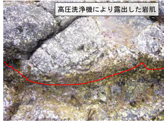
図 7-D5-5 高圧洗浄機による岩盤清掃
