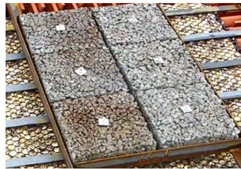
多孔質コンクリート版の設置状況
