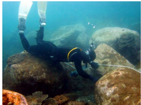
図 7-D1-6 作業区域を示すガイドロープ
