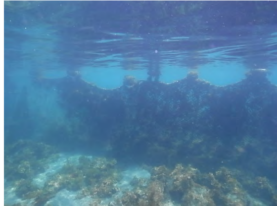
図 7-D3-6 海面に隙間が生じた仕切網
