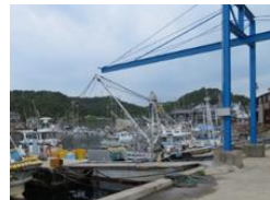
橋形クレーン
