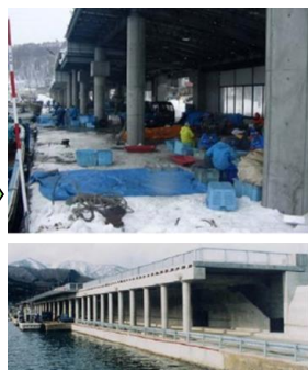
屋根付き岸壁（防風雪）
