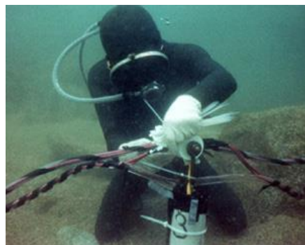
▲潜水士による爆薬装填
