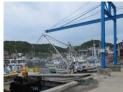
橋形クレーン
