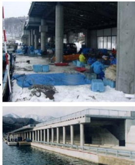
屋根付き岸壁（防風雪）
