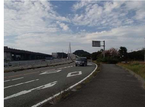
⑧浜田マリン大橋(原井地区側)
