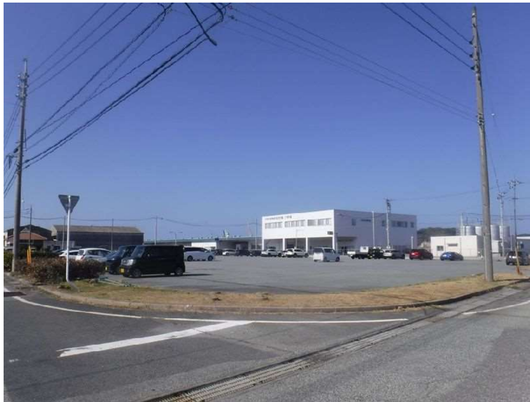
⑩冷凍及び冷蔵施設（建設予定地）
