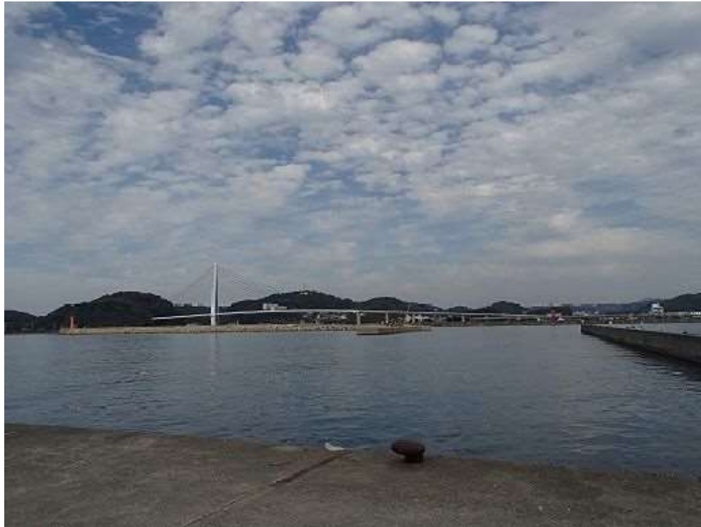
⑦浜田マリン大橋(遠景)
