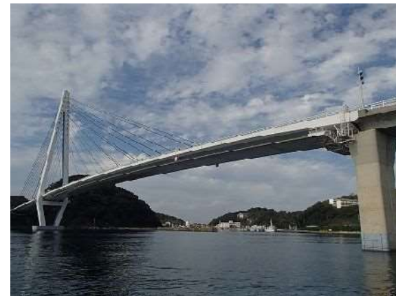
⑨浜田マリン大橋(近景)
