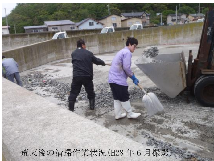
護岸からの越波状況(H28年8月撮影)
