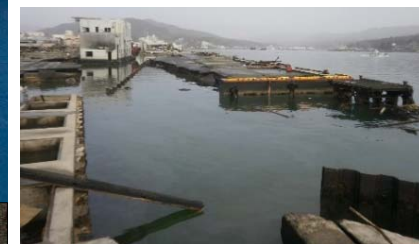
東日本大震災による被災状況
